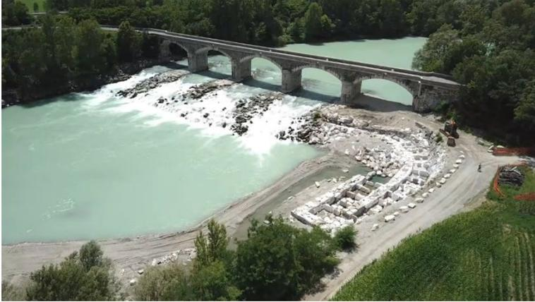
Figura 7 Passaggio ittico realizzato sul fiume Toce
